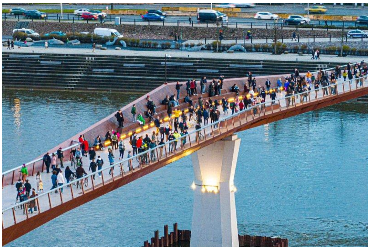
Fotografia 5.5 Kładka pieszo-rowerowa na Ursynowie w Warszawie
