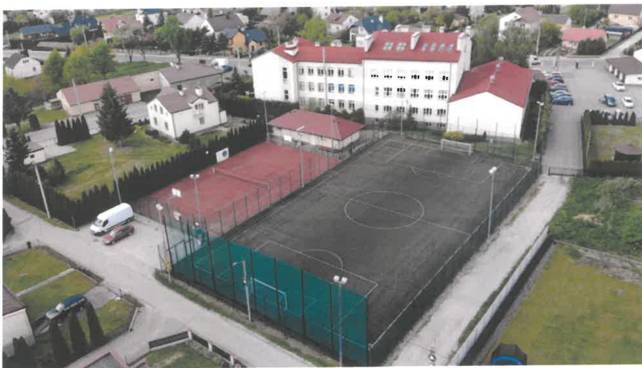
Fot 1. Szkoła Podstawowa im. Stanisława Dąmbkiego w Rudnej Wielkiej z oddziałami przedszkolnymi z widokiem na ORLIK
